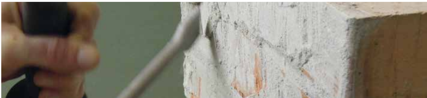
Retirez le crépi dans la zone endommagée
