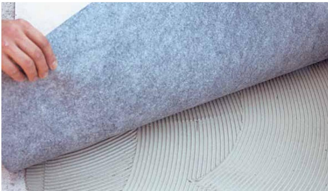
**CARATTERISTICHE TECNICHE:** Membrana impermeabilizzante per balconi, terrazzi ed in combinazione con gli impermeabilizzanti aderenti e le piastrelle negli ambienti umidi. Indicata anche come membrana desolidarizzante su sottofondi difficili e a rischio di fessurazione.
