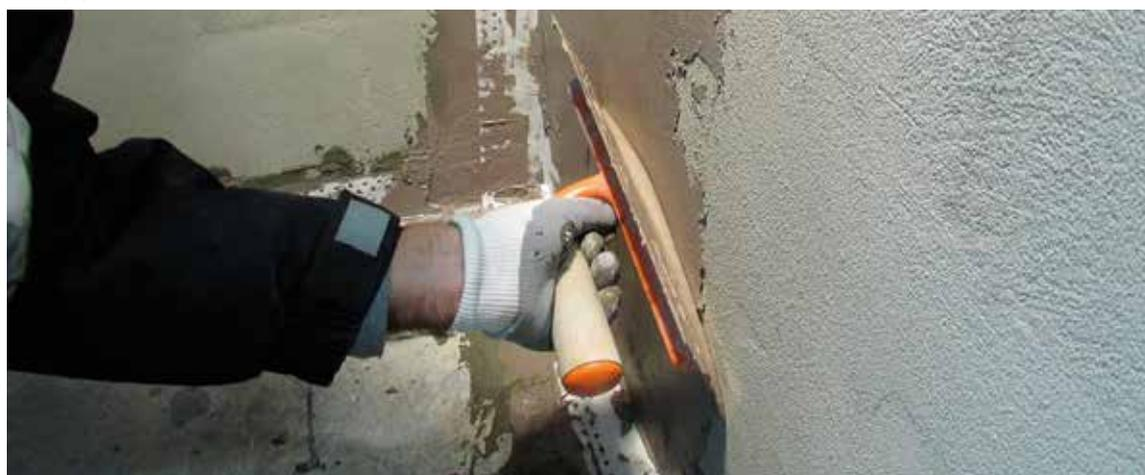
**CARATTERISTICHE TECNICHE:** Sistema impermeabilizzante aderente flessibile a base di cemento e polimeri, monocomponente per piastrelle con capacità di crack-bridging e basso consumo.
