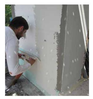
CARATTERISTICHE TECNICHE: BENFERPLASTER-FI è un adesivo/rasante in polvere fibrorinforzato per cappotto termico composto da cemento, inerti a granulometria scelta, fibre e resine sintetiche ed additivi speciali. La sua formulazione è stata concepita e sviluppata per incollare in modo rapido e sicuro i pannelli da isolamento a cappotto. Inoltre il prodotto si può utilizzare per la rasatura con interposta una rete in fibra di vetro sui pannelli isolanti e superfici in calcestruzzo.
