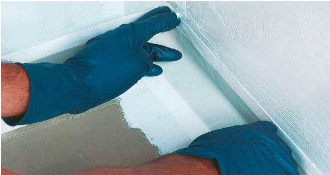
**CARATTERISTICHE TECNICHE:** BSWTAPE ECO è un nastro sigillante impermeabile, estensibile, resistente, stabile permeabile al vapore costituito da un tessuto di polipropilene con uno strato elastomerico termoplastico resistente all'invecchiamento. Garantisce la rapida essiccazione degli adesivi per piastrelle e degli impermeabilizzanti. BSWTAPE ECO è resistente alle sostanze aggressive.
