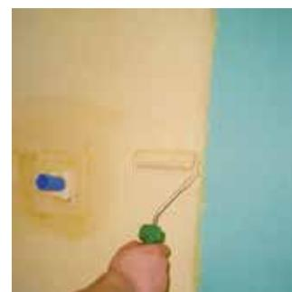
**CARATTERISTICHE TECNICHE:** ACQUASHIELD-GEL è una dispersione polimerica a base di gomma sintetica di consistenza liquida pronta all'uso che asciuga formando una membrana elastomerica impermeabile senza giunti. La membrana impermeabile fornisce una barriera elastomerica ancora permeabile al vapore con proprietà di crack bridging.
