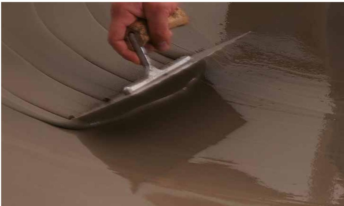
**AREA DI APPLICAZIONE:** MULTIPLAN-30 è utilizzato per lisciare e livellare in strati da 1 a 30 mm di spessore. Le superfici compatibili sono i pavimenti di cemento in accordo con gli standard industriali tedeschi DIN 1045, massetti riscaldati e non in conformità con DIN 18560, superficie di vecchie piastrelle e massetti cementizi a presa rapida (per esempio SOLIDONE PRONTO). Inoltre la superficie livellata non è adatta a rimanere senza un ulteriore rivestimento.
