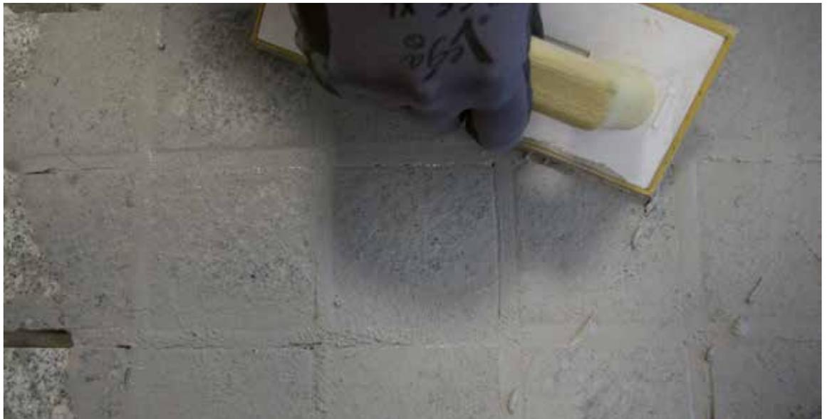
**CARATTERISTICHE TECNICHE:** Sigillante speciale flessibile, a presa rapida, per fughe da 3 a 30 mm di larghezza. I sigillanti DEKOGROUT-HF 1/30 sono composti da cementi speciali, inerti a granulometria scelta ed additivi e sono stati studiati per indurire rapidamente e con ritiri minimi sino ad assumere elevate resistenze meccaniche, buona flessibilità e minimo assorbimento d'acqua unitamente ad un bell'effetto estetico.
