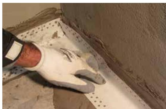
**CARATTERISTICHE TECNICHE:** ACQUASHIELD-2KF è un rivestimento elastomerico flessibile bicomponente modificato con polimeri, che impermeabilizza e protegge calcestruzzo, murature, mattoni e alcuni sottofondi di pietra naturale, con capacità di crack-bridging.
